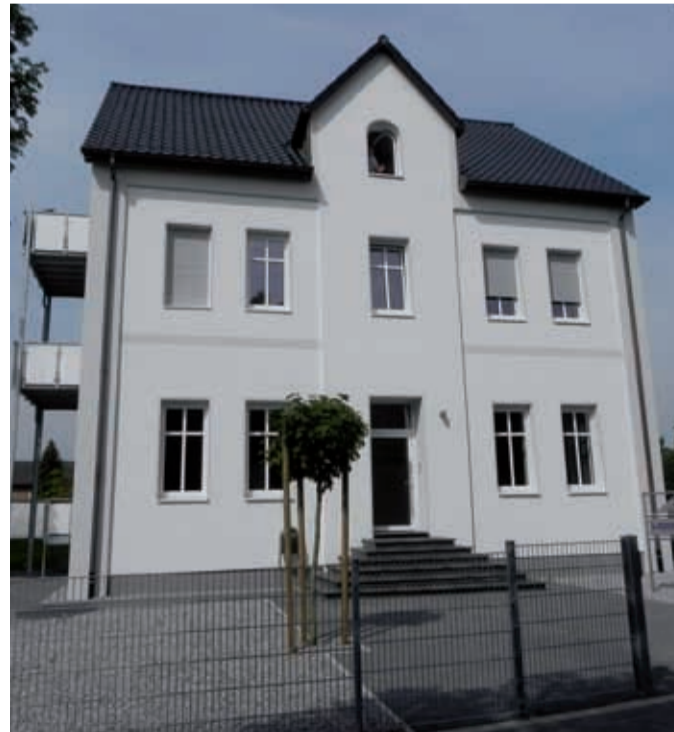
Das neue Schmuckkästchen nach den umfangreichen Sanierungs- und Umbauarbeiten. Foto: fjd
